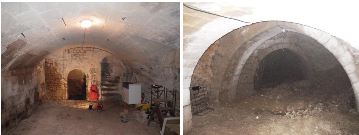
Illustration 14 – Photo de cavités parées de pierres de taille (n°1061 à gauche et n°2115 à droite)
