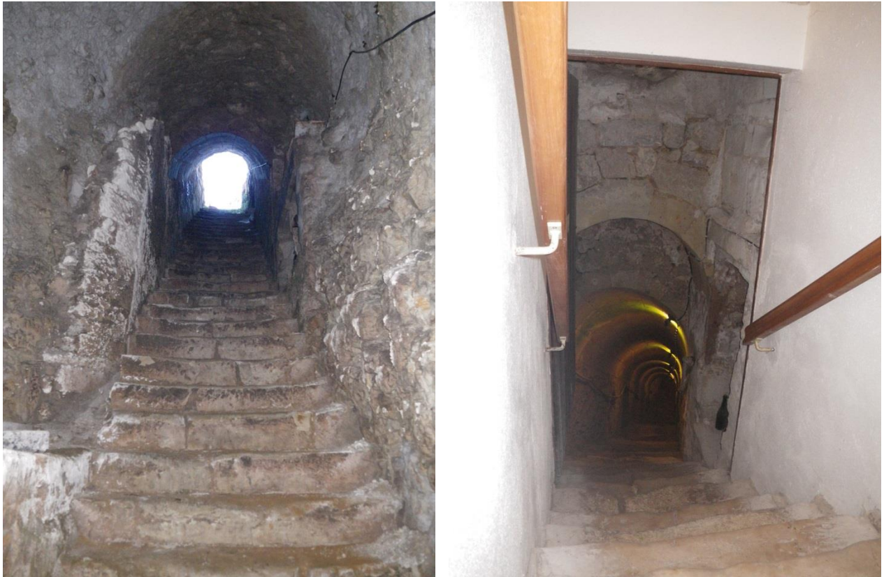
Illustration 16 – Photos d'accès par escalier (à gauche cavité rue de la Porte de Mirebeau, à droite cavité située petite rue du Jeu de Paume)
